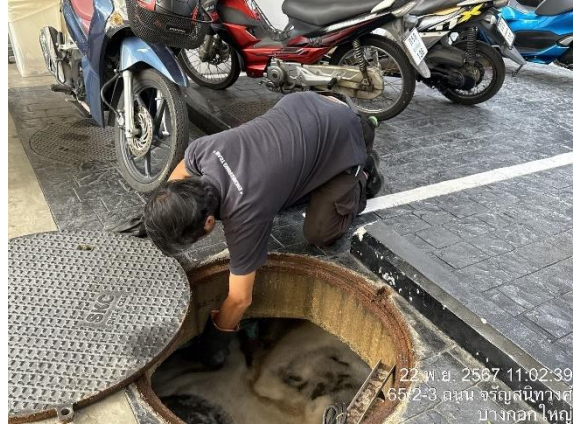
รูปที่ 3-32 ช่างเทคนิคตรวจสอบตู้ควบคุมและระบบบำบัดน้ำเสีย
