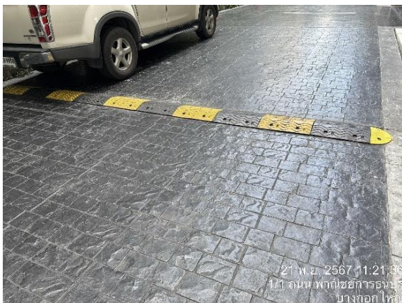
รูปที่ 3-11 กระຈกนูนและยางชะลอรถ
