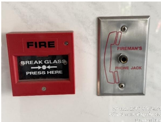
รูป 3-22.8 Manual Switch และ Telephone Jack
