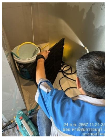
รูปที่ 3-23 ล้างเครื่องปรับอากาศและฟิเตอร์ส่วนกลาง
