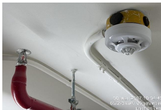
รูป 3.22.5 เครื่องจับความร้อนและสปริงเกอร์
