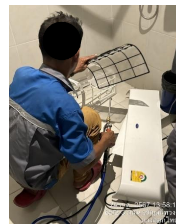
รูปที่ 3-23 ล้างเครื่องปรับอากาศและฟิเตอร์ส่วนกลาง
