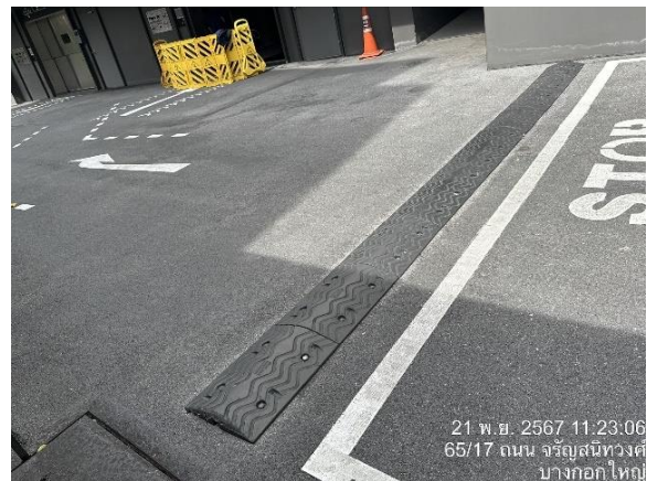
รูปที่ 3-11 กระຈกนูนและยางชะลอรถ
