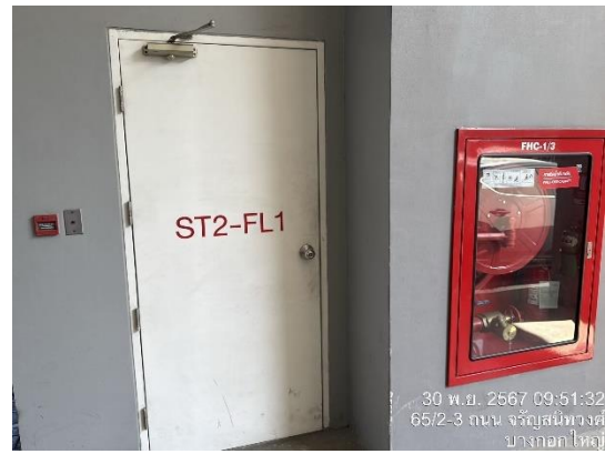
รูป 3-22.12 บันไดหนีไฟ ST1 กับ ST2 และตู้เก็บสายฉีดน้ำ
